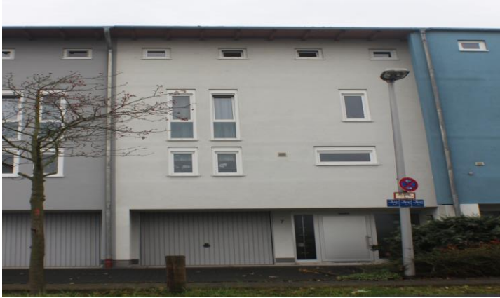
Reihenmittelhaus – Mörfelden - Walldorf
