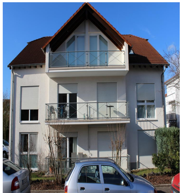
Mörfelden – Walldorf – 12 Parteienhaus
