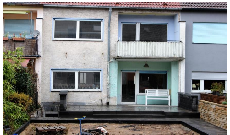
Reihenmittelhaus - Mörfelden - Walldorf
