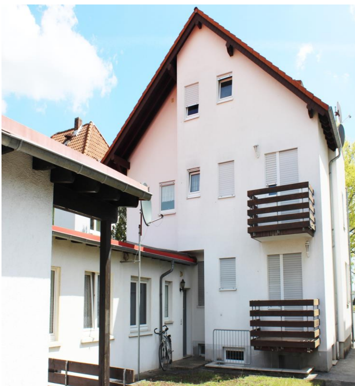
Mörfelden – Walldorf – 6 Parteienhaus
