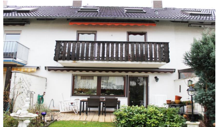
Reihenmittelhaus - Mörfelden - Walldorf
