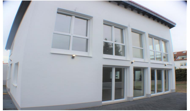
Neubau: Einfamilienhaus - Mörfelden - Walldorf
